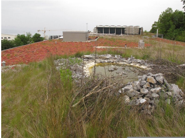
Chemin des roches, Lausanne
